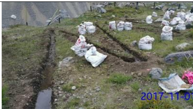
Marcación de surcos con uso de Nivel y vara graduada.
